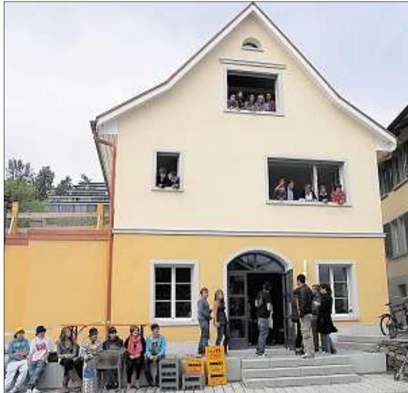
Drei Geschosse für die Jugend: Das neue Jugi in Herrliberg wird nach den Sommerferien viel mehr Möglichkeiten bieten als das Provisorium. (Christian Dietz-Saluz)
